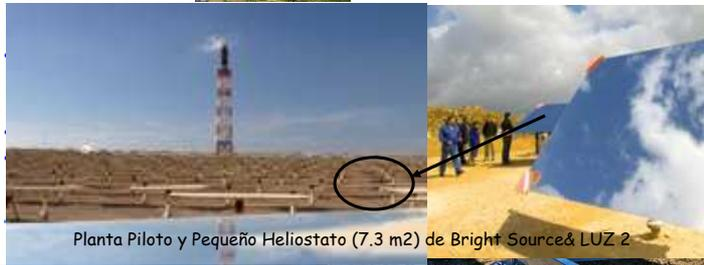
Planta Piloto y Pequeño Heliostato (7.3 m<sup>2</sup>) de Bright Source & LUZ 2
